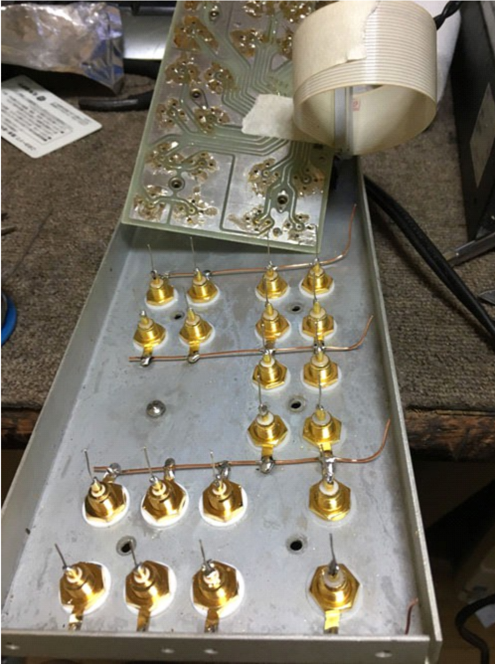
RCA端子の全交換 (FUSEホルダーも交換)
