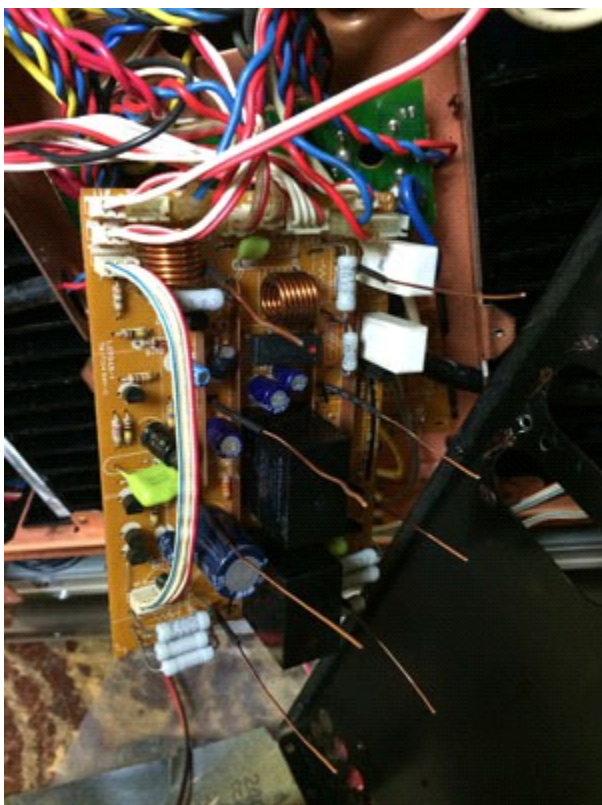
スピーカー基盤取付時（シャーシとの隙間も良好）
