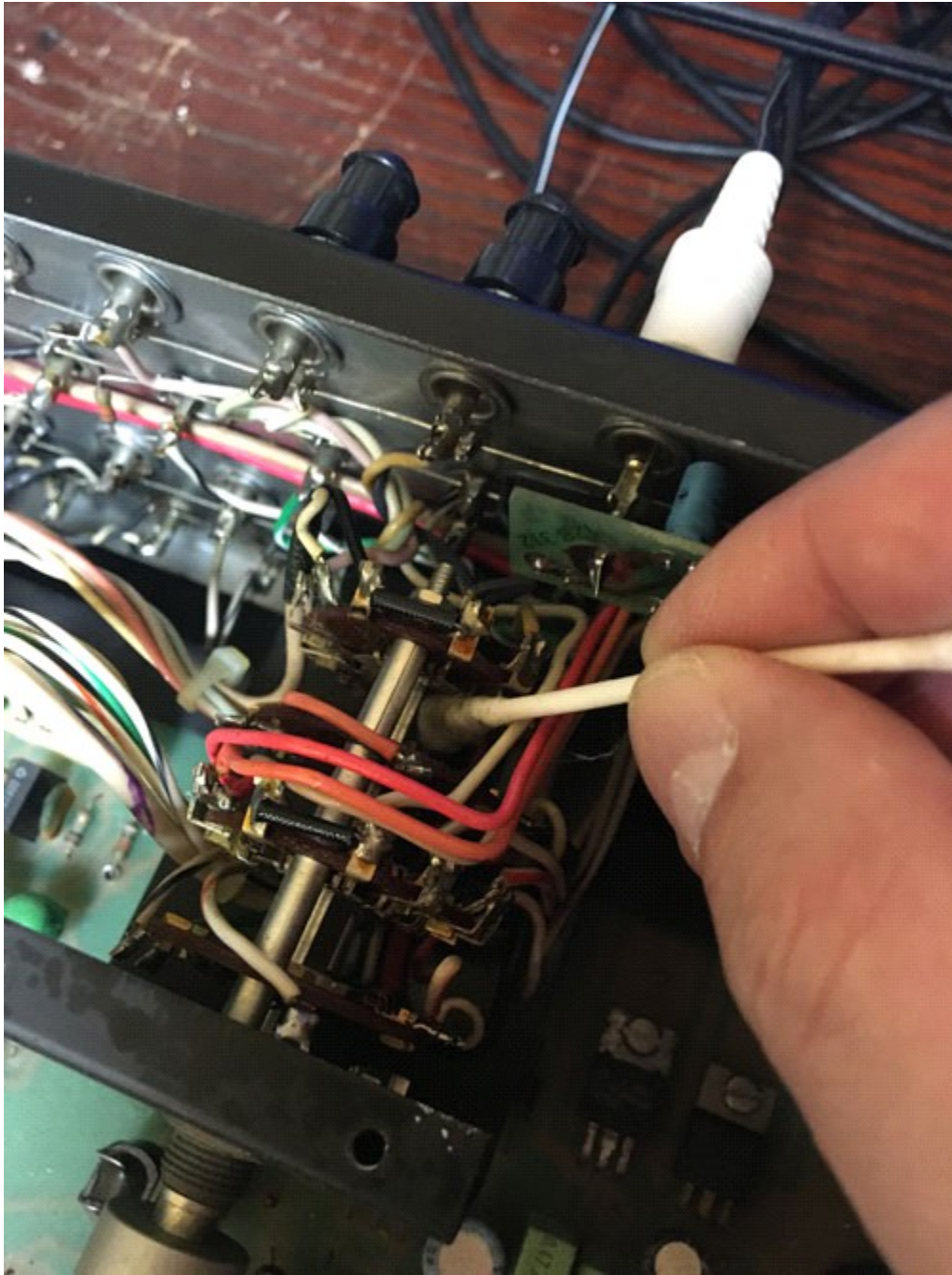
清掃後の状況
