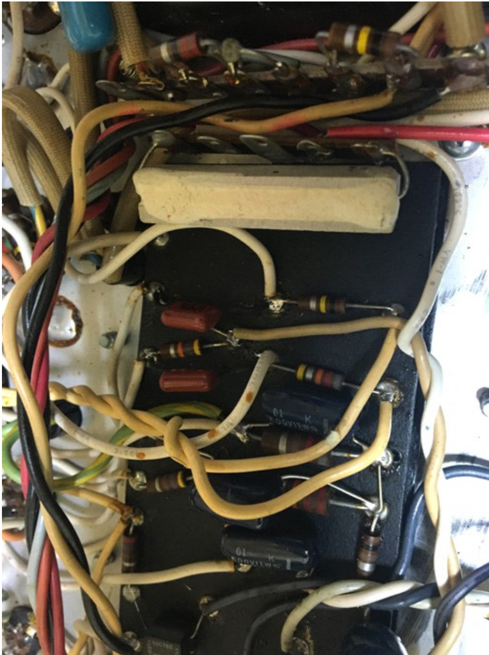
劣化コンデンサー交換
